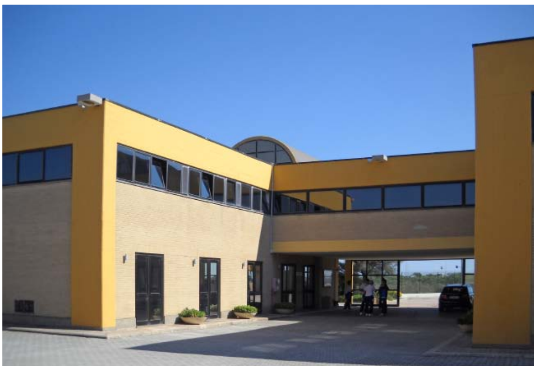
Il lato posteriore della Sala Monticelli. Sulla sinistra sono parzialmente visibili gli altri locali del Museo
