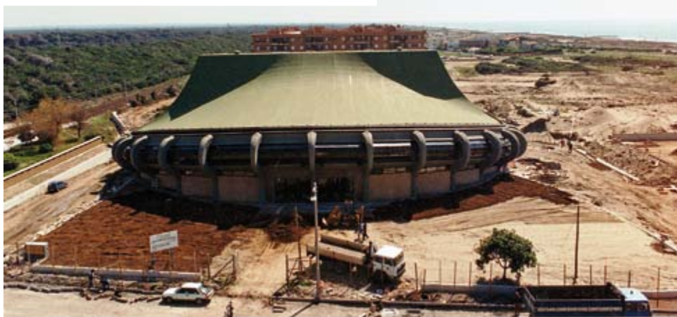
Il Palazzetto della Fijlkam alla fine dei lavori
