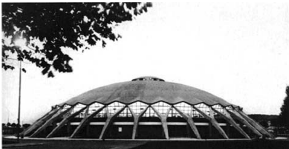
Il Palazzetto dello Sport a Via Flaminia
