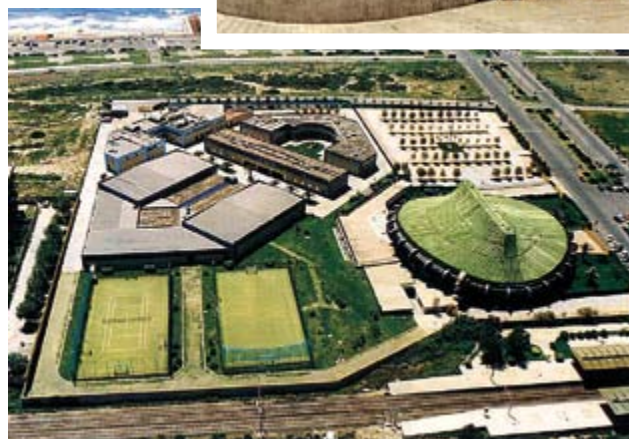
Foto aerea del Palazzetto e del Centro di preparazione olimpica (veduta dalla pineta)
