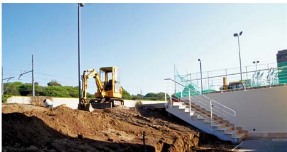
Mezzi al lavoro all'esterno
